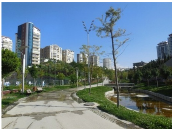
【写真1】3Etap 地区の様子
