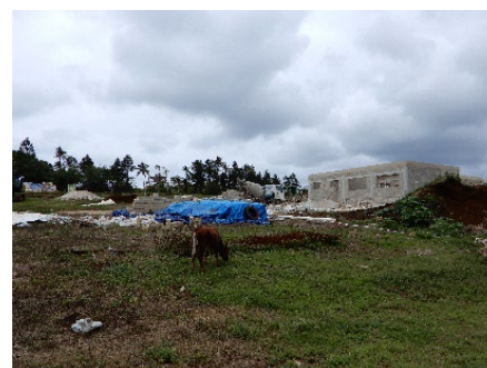
写真4_建設中の政府機関の建物
