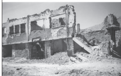
破壊されたカブール大学
