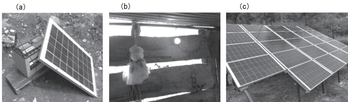
写真 4. ラメチャップ郡 B 村 (a) 各家庭の太陽光パネル (b) 太陽光パネル(a)によって灯される明かり (c) ソーラーポンピングシステム用の太陽光パネル
